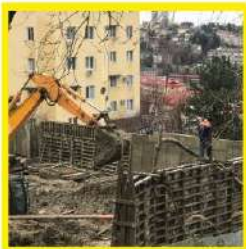
Подпорные стены г.Сочи
