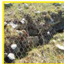
Сооружения инженерной защиты г.Сочи
